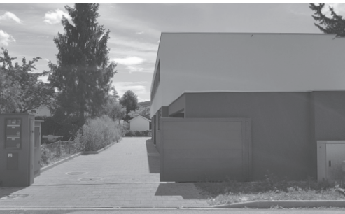
Façade aveugle, garage en limite de propriété, absence de végétation, création d'une nouvelle desserte privée
