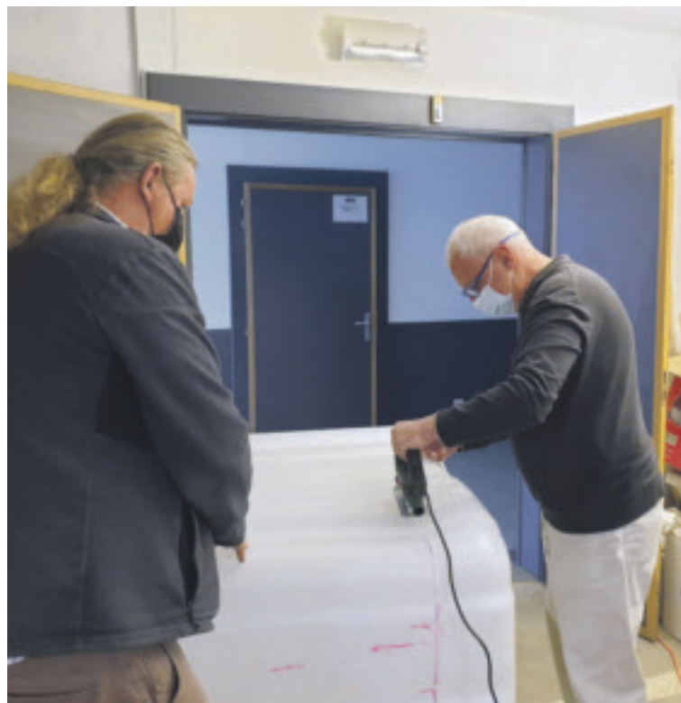
Découpage de la cuve à la scie électrique... et donc pas par les élèves, ce serait dangereux !
