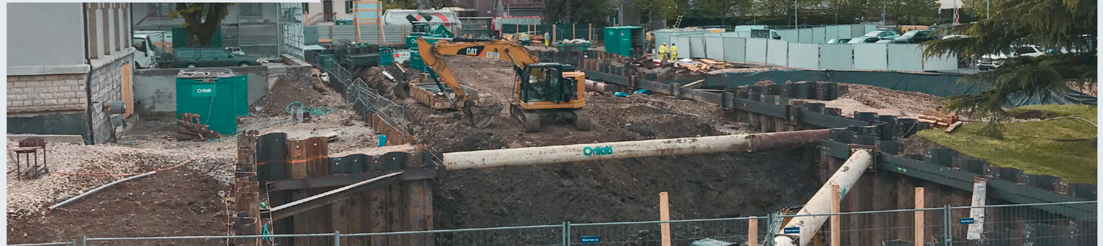
Le chantier du nouveau bâtiment administratif a débuté en novembre 2018. © Commune de Thônex
