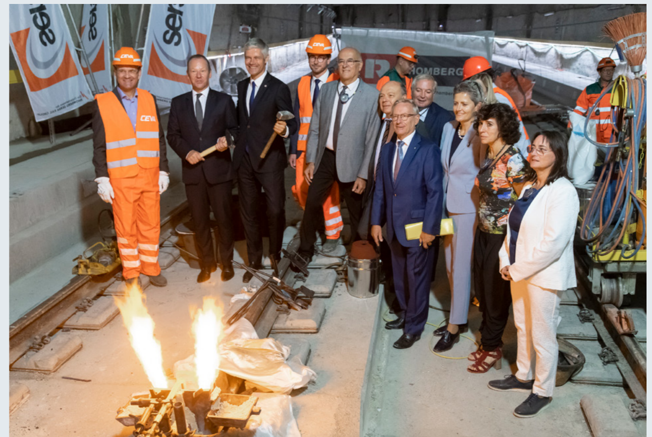
Jonction des rails Suisse-France le 21 septembre 2018. © CEVA et Groupe 13.76, O. Zimmermann
