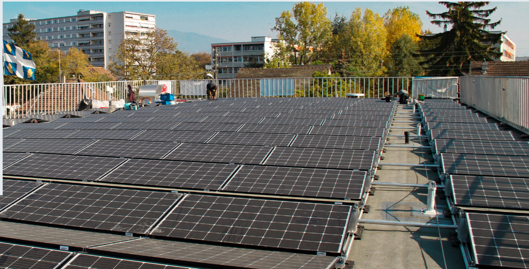
282 panneaux photovoltaïques ont été installés sur le toit de la piscine. © Commune de Thônex
