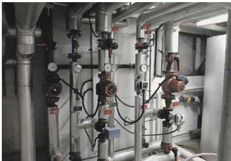
Système de chauffage à distance.
