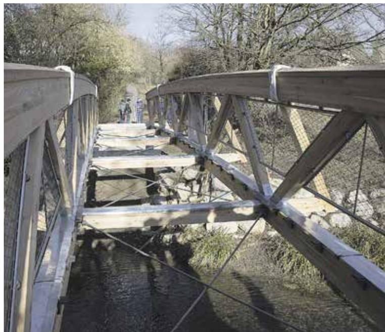
**POUR CELA, IL A FALLU ENLEVER** l'ancienne passerelle datant de 1979. Ne remplissant plus les conditions d'exploitation sécurisées, celle-ci a dû en effet être fermée et rendue interdite d'accès pendant plus d'un an. Les chemins alentours ne permettant pas d'amener un camion ou une autogruë à proximité du lieu de franchissement de la Seymaz, le levage a
