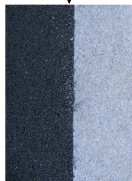
Chaussée Enrobé & granit
