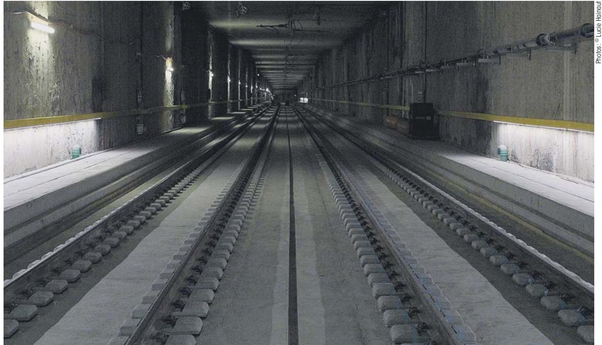
La tranchée couverte où circuleront les rames du CEVA. Il y aura jusqu'à 6 trains par heure et par sens, en semaine.
