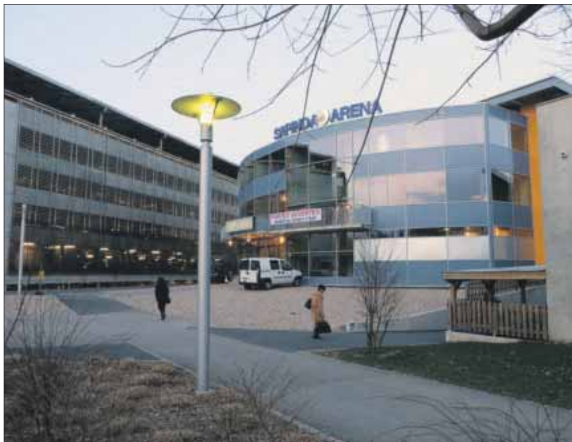
Vue du P+R de Sous-Moulin et de la halle de curling.
